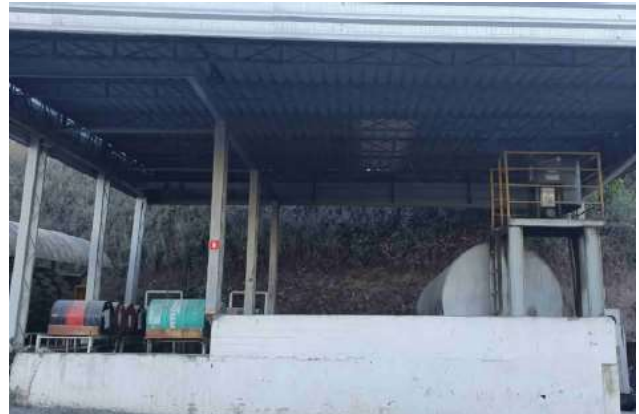
Vista externa do ponto de abastecimento (Fonte: RTS)
