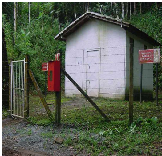
Paiol de explosivos. Fonte: RIMA (2019) Petra MG
