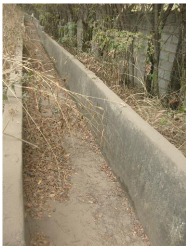
Foto 5: Canaleta de drenagem de água pluvial.
