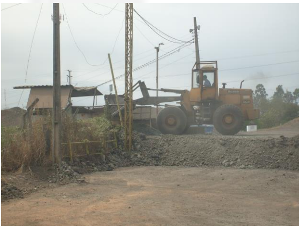
Foto 3: Carregamento do silo.
