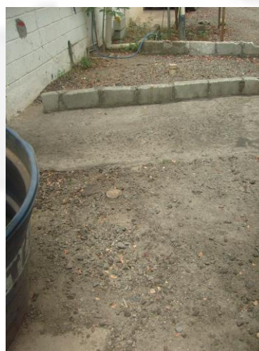
Foto 10: Sistema de fossa/ filtro/ sumidouro.
