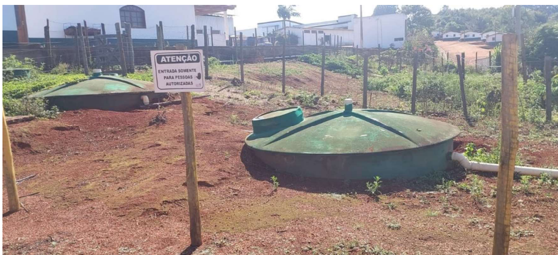
Foto 06: Fossa Septica/Biodigestor instalado em todas as estruturas da Fazenda e Residências
