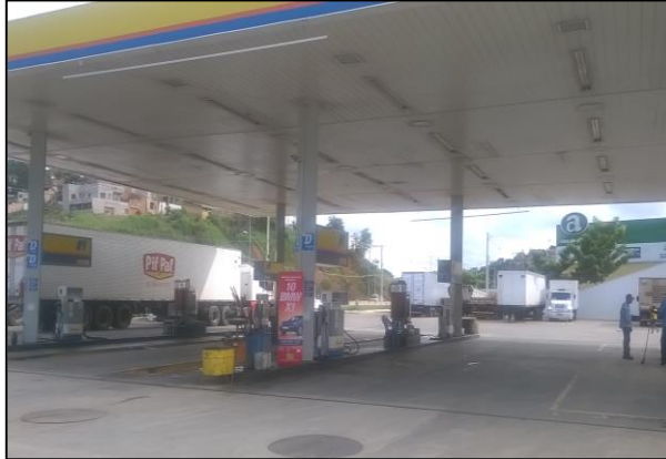
Foto 01. Vista geral da pista de abastecimento.
