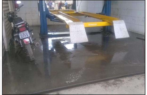
Foto 02. Área para troca de óleo de veículos.
