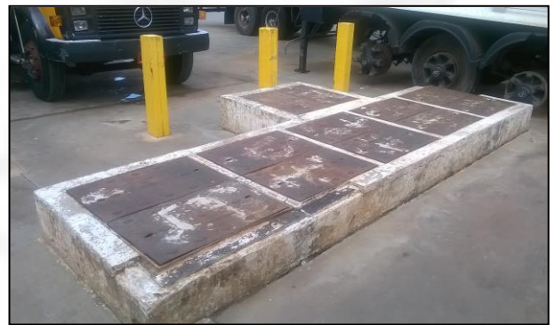
Foto 04. Caixa Separadora de Água e Óleo-SAO.
