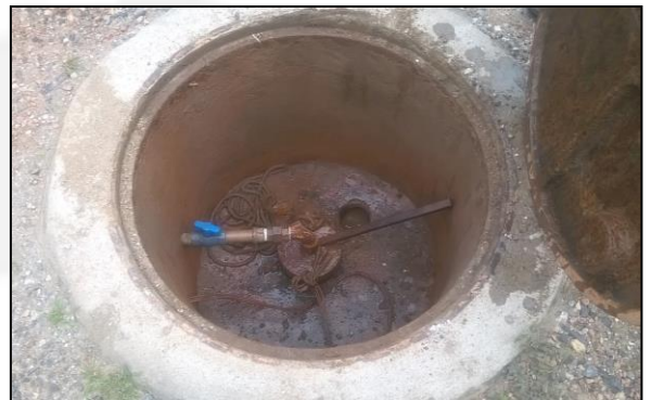
Foto 04. Caixa Separadora de Água e Óleo-SAO.
