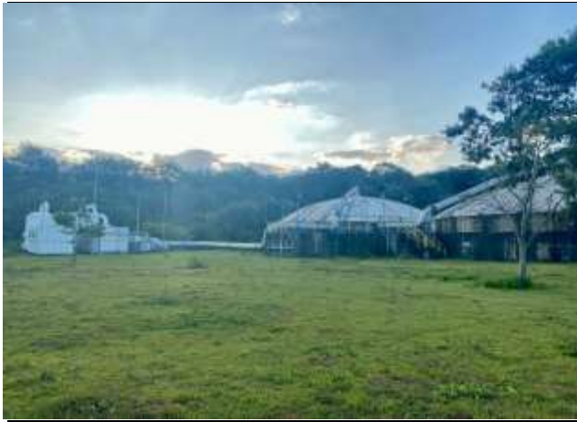
FOTO 7 – Adensadores por gravidade.
