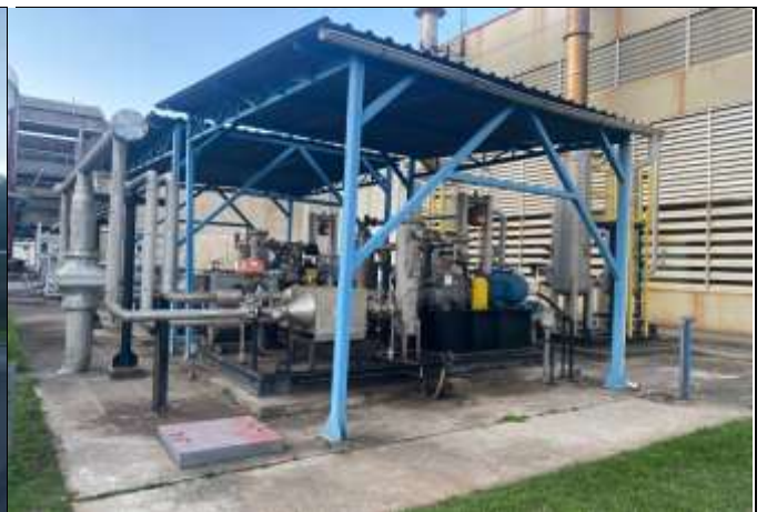
FOTO 12 – Tratamento do biogás na PCT.
