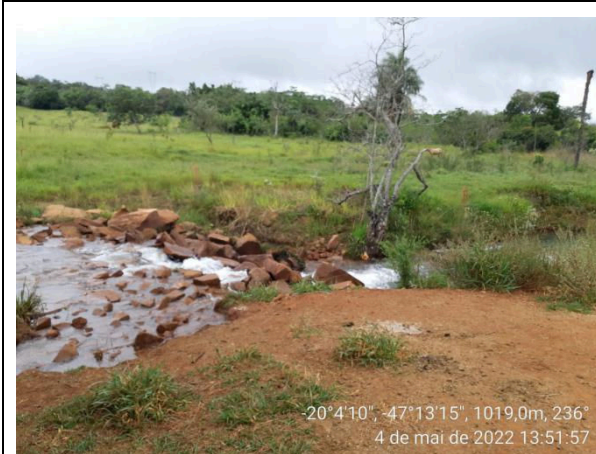
Foto 9. Área que será ocupada por barramento a ser instalado
