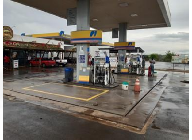
Foto 02. Posta de abastecimento com canaletas
