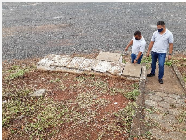
Foto 11. Caixa separadora de água e óleo
