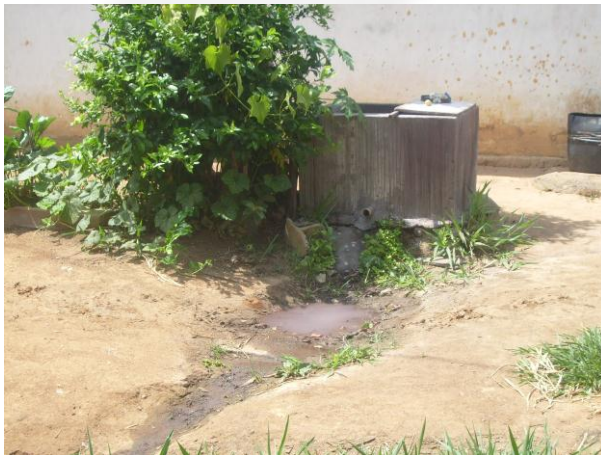
Foto 29: Pia sem direcionamento dos efluentes líquidos sanitários para tratamento.
