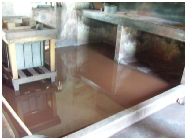
Foto 17: Galpão com lâmina d'água.
