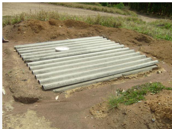
Foto 18: Caixa de alvenaria para o armazenamento de efluente líquido industrial da lâmina d'água.
