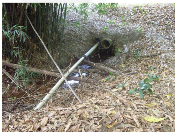
Foto 21: Tubulação da captação em barramento.
