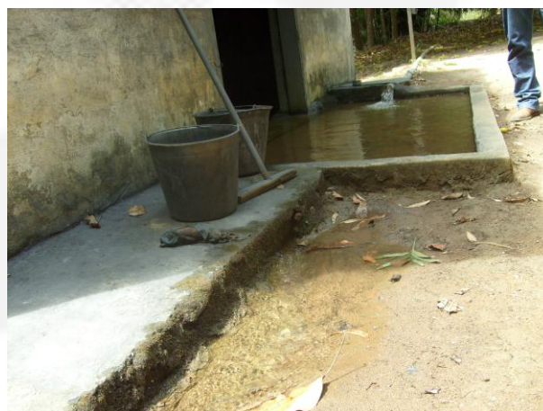
Foto 22: Lâmina d'água do galpão 23, com abastecimento direto da captação em barramento. Detalhe para lançamento do efluente diretamente em solo.
