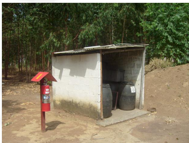
Foto 14: Depósito de cinzas.
