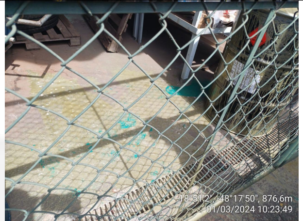
Foto 18: Canaleta com grelha para captação de efluentes (central de armazenamento de resíduos sólidos)
