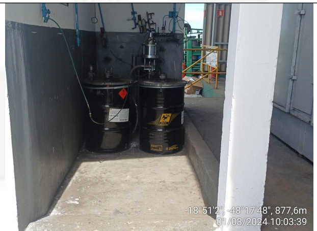
-18°51'2", -48°17'48", 877,6m 01/03/2024 10:03:39 Foto 16: Local de armazenamento de tambores de tinta em utilização
