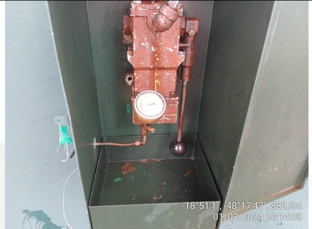
-18°51'1", -48°17'47", 883,3m 01/03/2024 10:14:00 Foto 12: Macaco hidráulico e "casinha" com mini bacia de contenção
