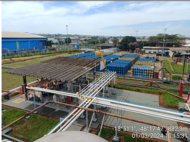
-18°51'1", -48°17'47", 882,3m 01/03/2024 10:15:31 Foto 13: Visão geral - pátio de armazenamento de vasilhames e casa de máquinas da operação
