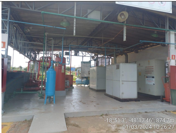
Foto 19: Casa de máquinas - sistema de combate a incêndios
