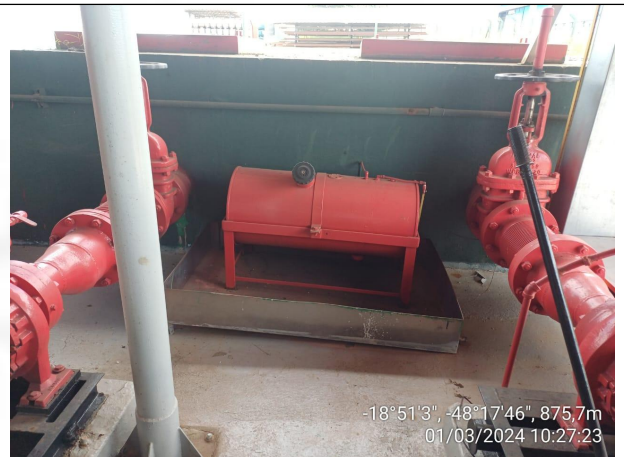
Foto 20: Reservatório de gasolina sobre bacia de contenção
