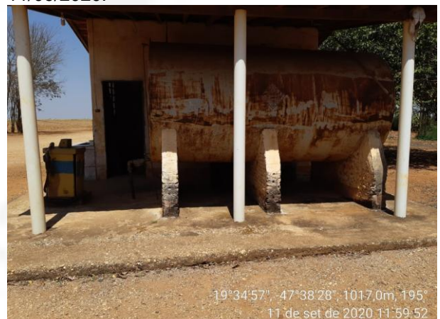
Figura 14. Área de abastecimento de combustível, continua desativada (fazenda São José), em 11/09/2020.
