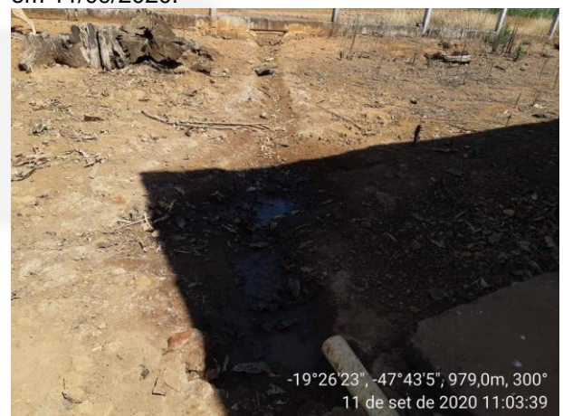
Figura 4. Lançamento do efluente da caixa separadora de água e óleo (fazenda Santa Maria) em 11/09/2020.
