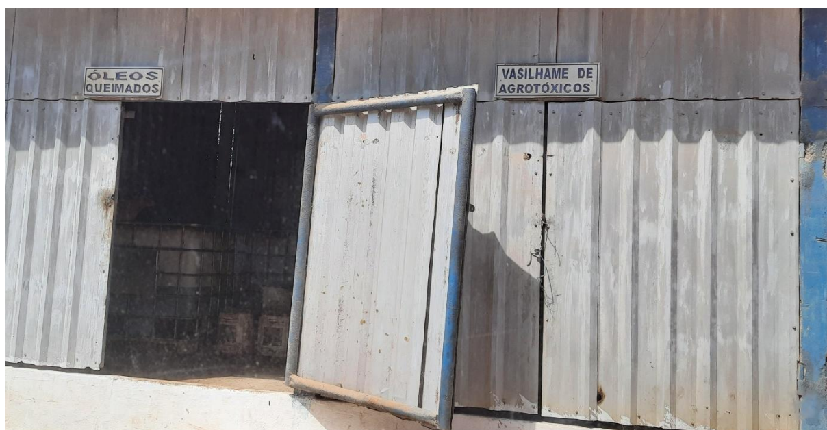
Depósito de embalagens de agrotóxicos e óleo usado (imagem obtida em vistoria realizada em 25/10/2022)
