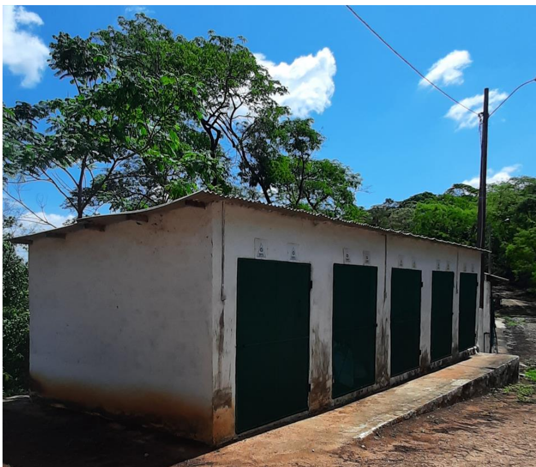
Depósito Temporário de Resíduos (DTR)
