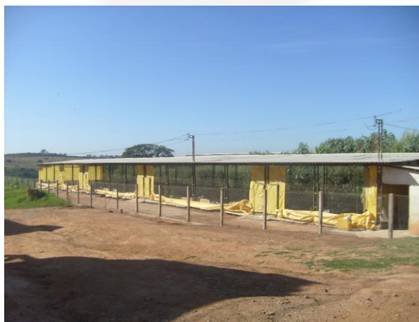
Foto 01. Galpão de aves.
