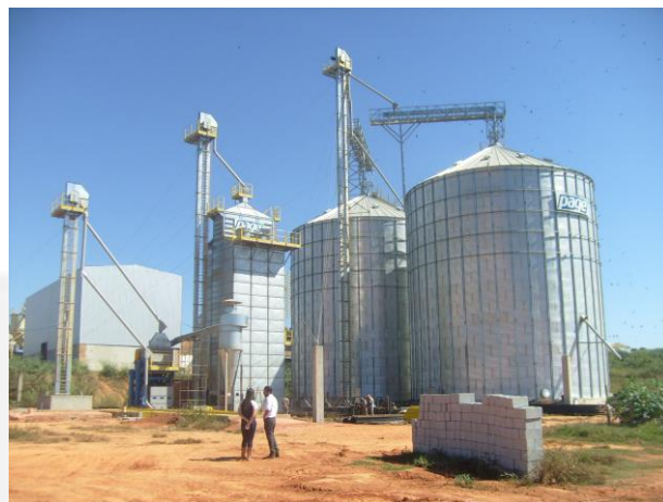
Foto 06. Silos e fábrica de ração.
