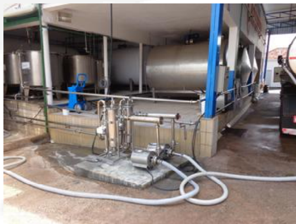
Foto 02. Área de recebimento de leite onde será instalada cobertura aérea
