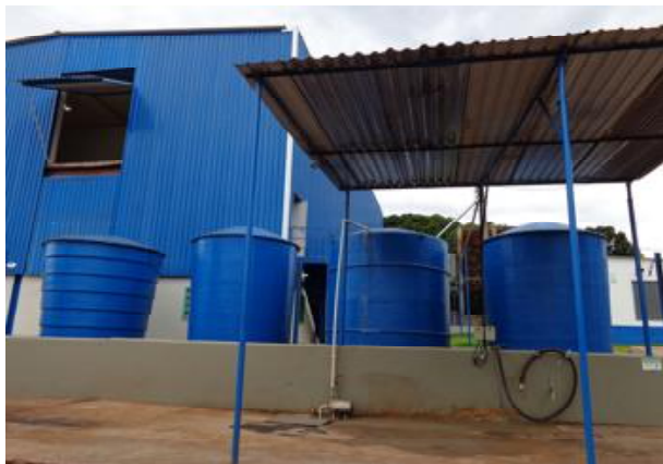
Foto 05. Tanques de armazenamento de soro
