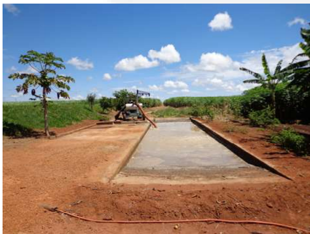
Foto 15. Tanque com motobomba
