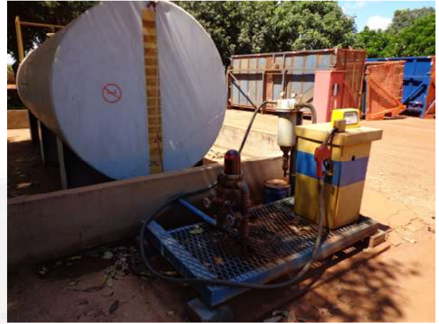
Foto 12. Ponto de abastecimento
