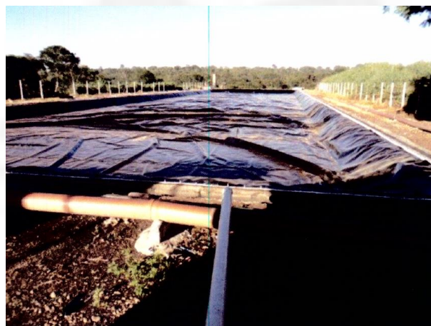
Foto 11. Biodigestor após manutenção.
