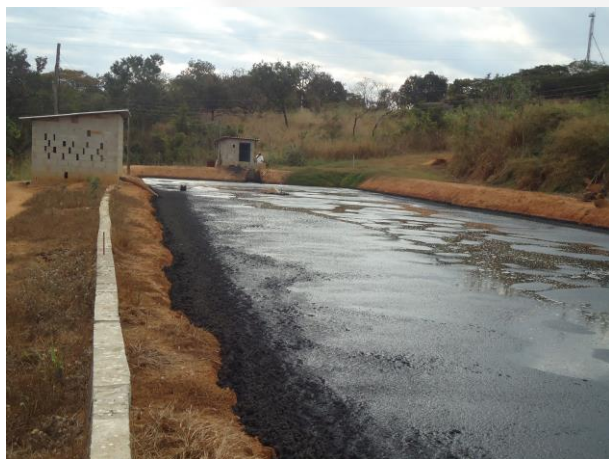
Foto 12. Antiga lagoa após o biodigestor.
