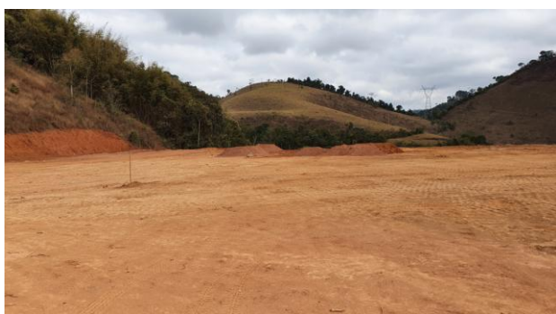
Platô, localizado a jusante da lagoa de acumulação de percolato, onde será implantado o sistema de tratamento de efluentes.
