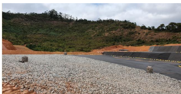
Aterro de resíduos de Classe II
