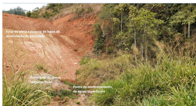
Final do platô e do dreno subsuperficial.
