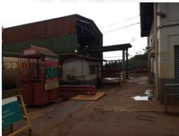
Figura 7: Instalação de combate a incêndio
