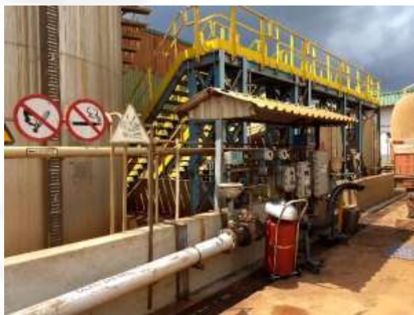
Figura 5: Área de descarga de combustível
