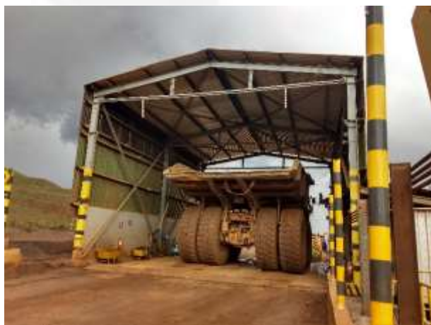
Figura 6: Galpão de abastecimento - Entrada.
