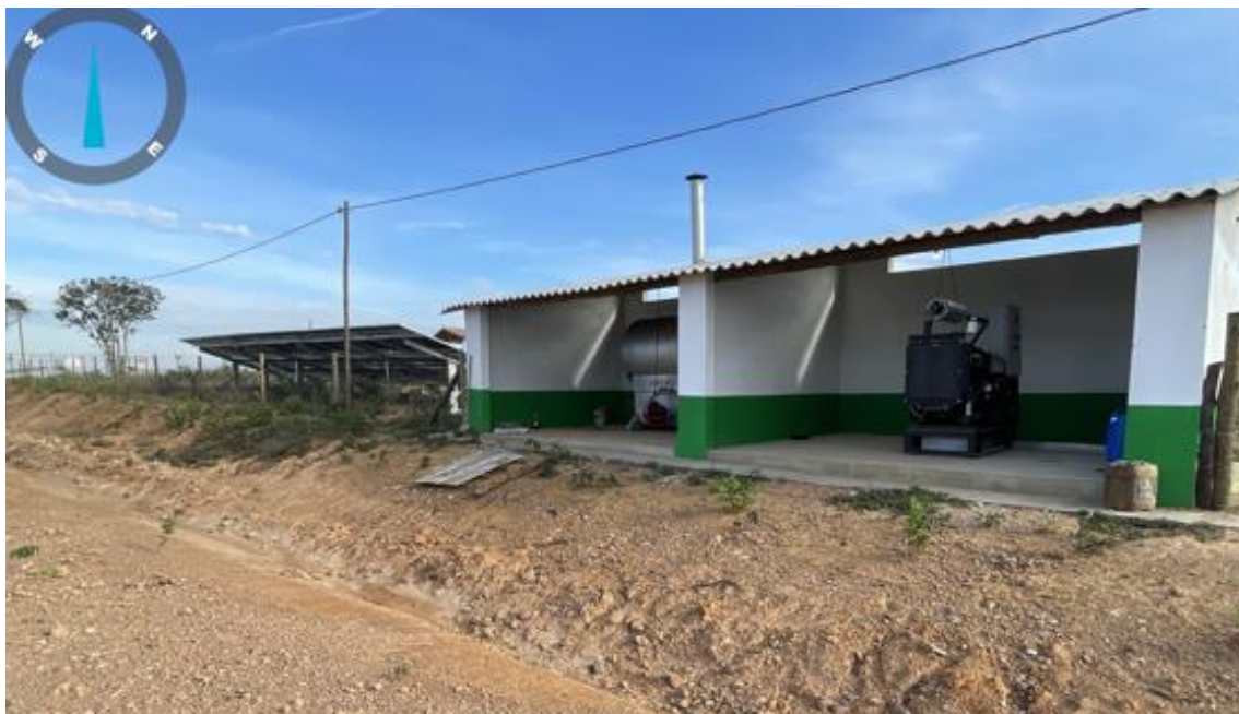
Foto 08 – Da esquerda para direita: área para instalação dos painéis de energia fotovoltaica, o desidratador e do gerador. Todos com acesso voltados para o interior da granja com porta de acesso controlado para área externa cercada com tela.
