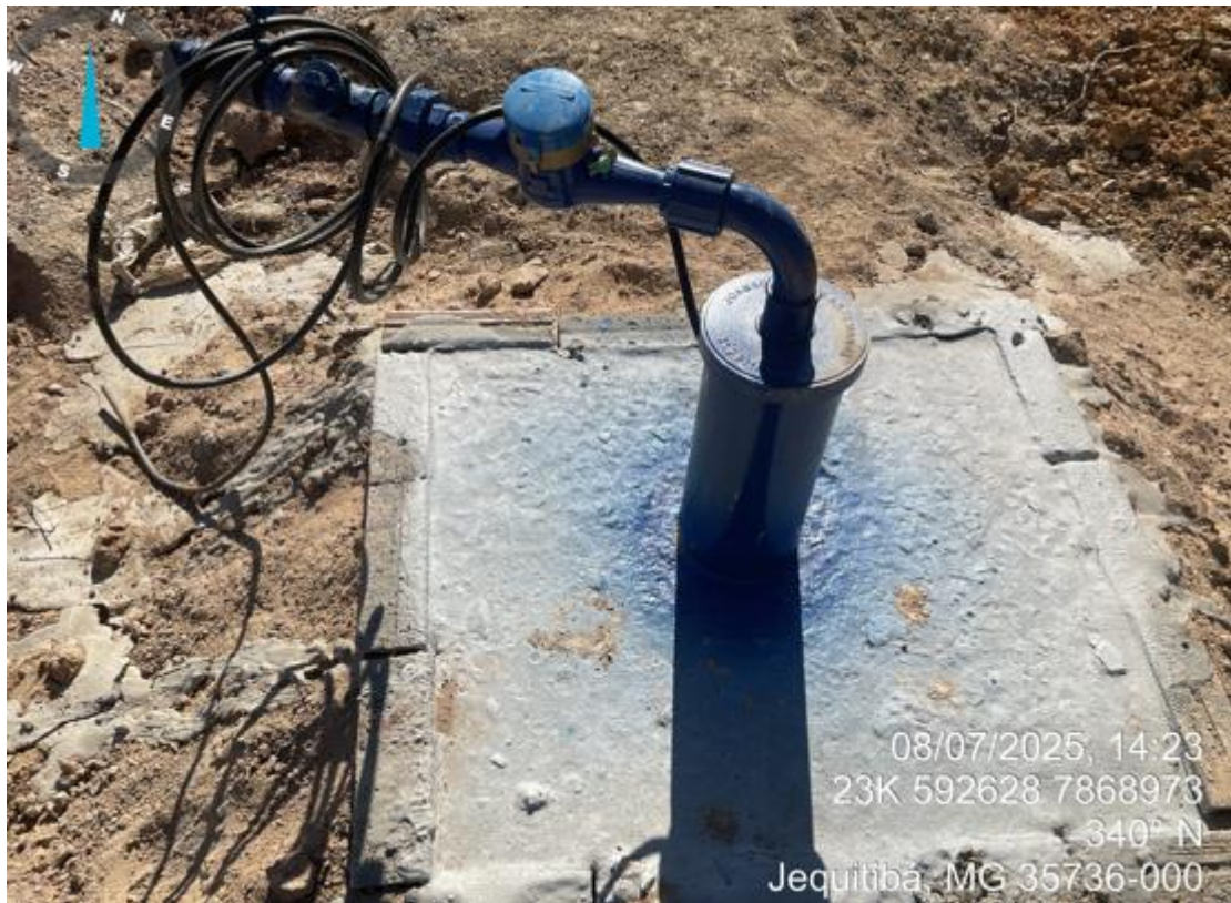
Foto 04 – Instalação dos equipamentos no poço tubular e sem ligação da energia.
