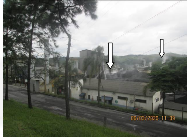
Foto 02. Sistema clean air na área dos fornos (SiC)
