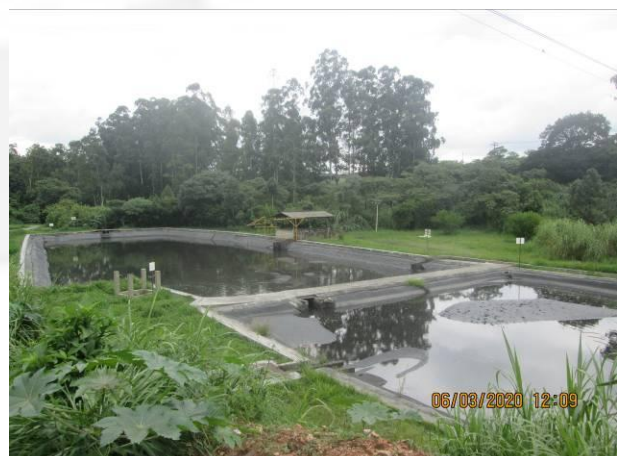
Foto 06. ETE industrial do 1º grupo de fornos
