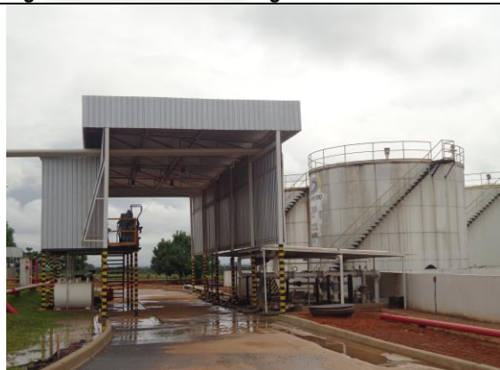
Figura 5- Plataforma de descarregamento (rodoviária, não sofreu ampliação)
