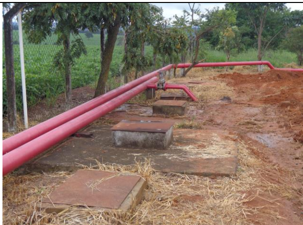
Figura 9 - Fossa Séptica seguida de Filtro Anaeróbio
