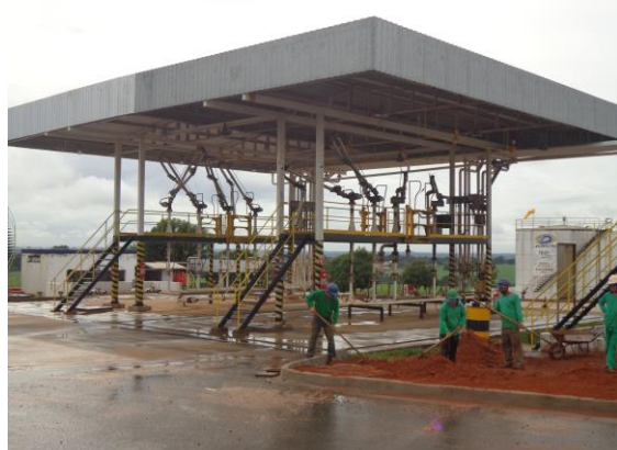
Figura 3- Plataforma de carregamento rodoviário
