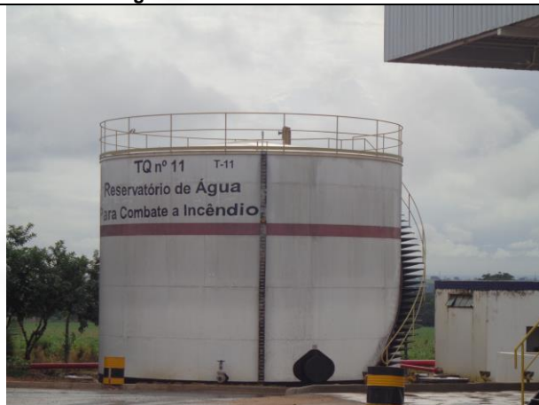
Figura 12- Reservatório de Água para controle de incêndio
