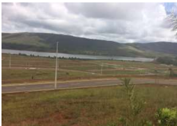
Foto 03. Pavimentação das vias.
