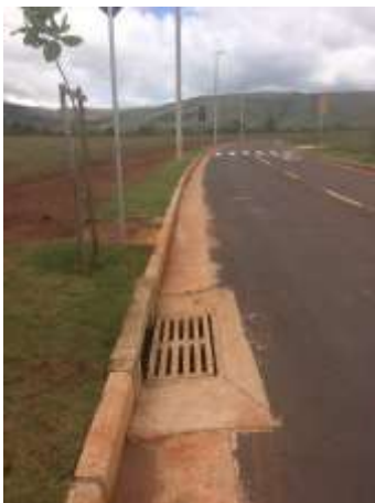
Foto 01. Drenagem e sinalização.
