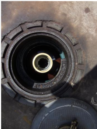
Figura 4- Boca de descarga á distância
