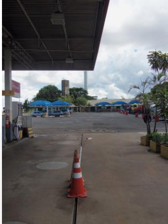
Figura 2- Projecção da cobertura da área de abastecimento e das canaletas de drenagem
