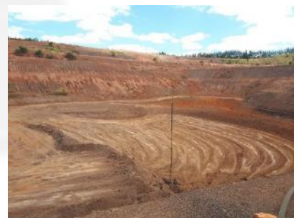
Figura 8. Barragem de rejeito
