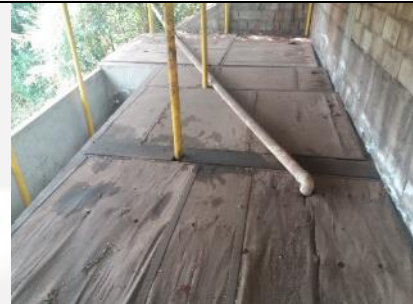
Figura 12. Atual caixa separadora de água e óleo
