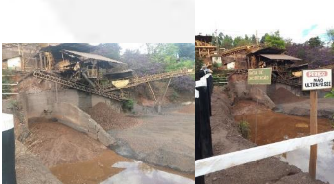
Figura 7. Bacia de decantação
