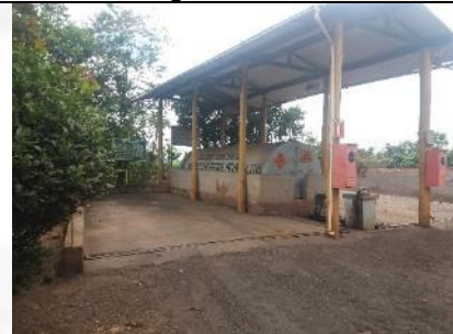
Figura 14. Ponto de abastecimento
