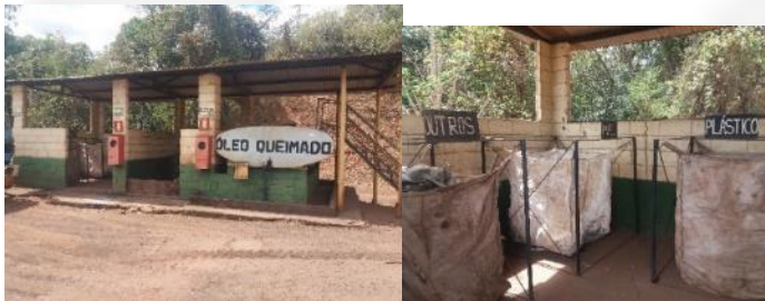
Figura 13. Depósito de resíduos
