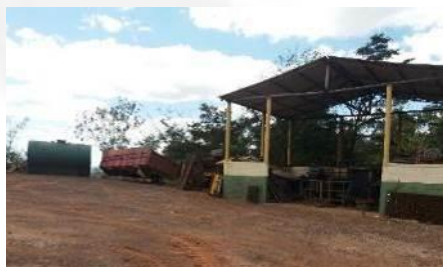
Figura 15. Depósito de sucata
