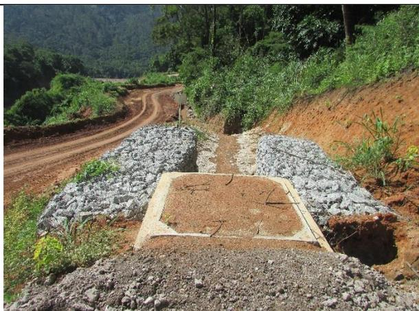
**Fotografia 03:** Adaptação da linha de escoamento pluvial da bacia a montante da Pilha de Rejeitos da Voçoroca.
