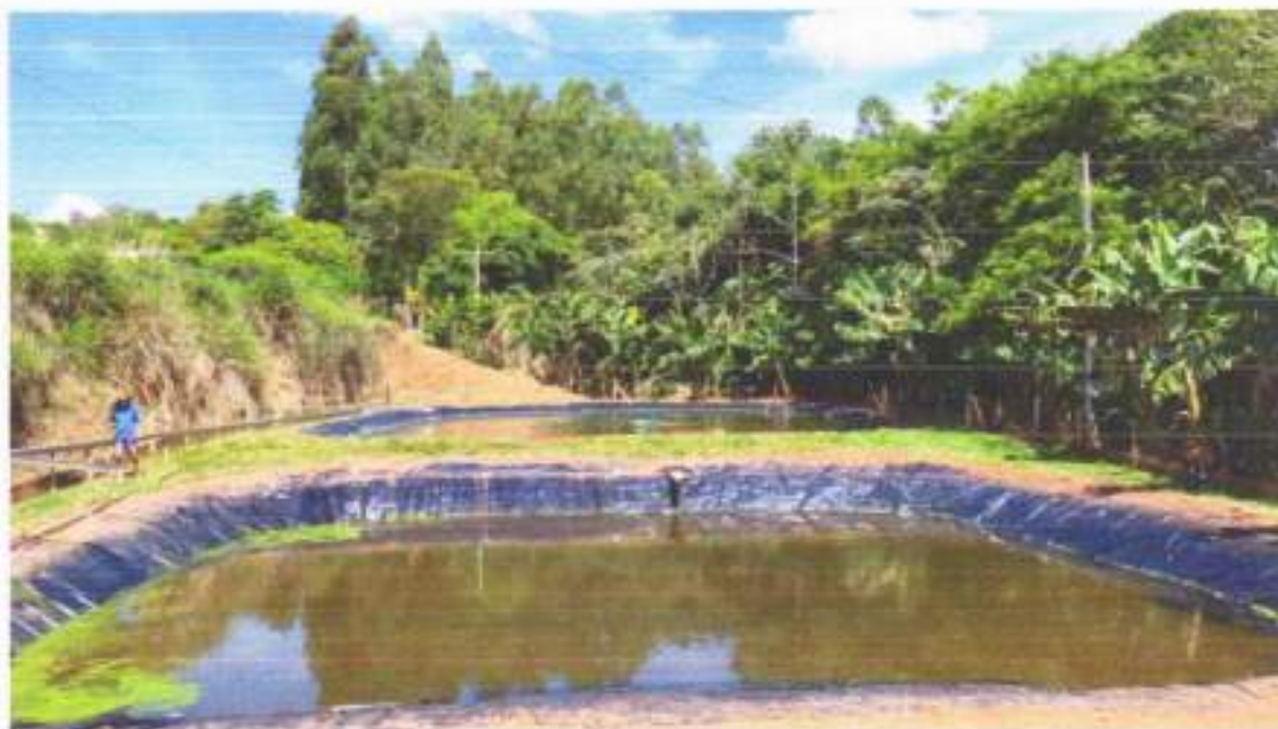
1. Sistema de Lagoa Facultativa, sistema utilizado anteriormente.
