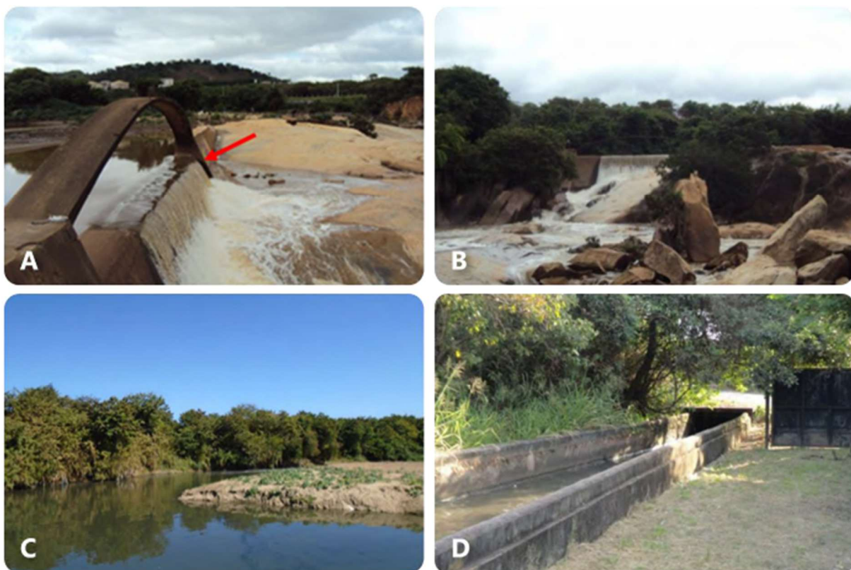
Figura 2.3: Estrutura tomada de água no ribeirão Arrudas. Fonte: RCA Fertiligas. Nota: A – Barragem com vertedouro; B – Vista do vertedouro; C - Reservatório; D – Canal de adução.
