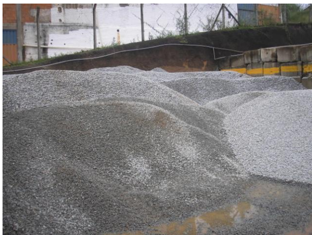
Foto 01. Pátio de agregados.
