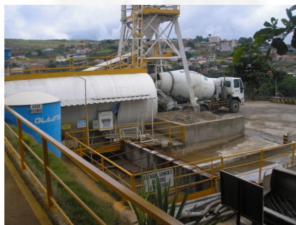
Foto 04. Visão da planta da Central Beton
