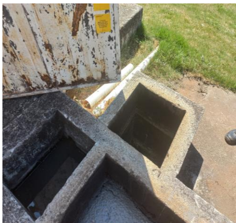
Foto 01. Caixa Separadora de Água e Óleo - SAO do lavador de veículos, lavador de embalagens e da oficina
