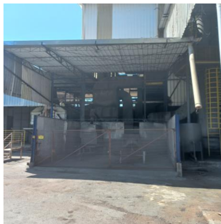
Foto 02. Tratamento das emissões atmosféricas geradas pela caldeira, Filtro Multiciclone
