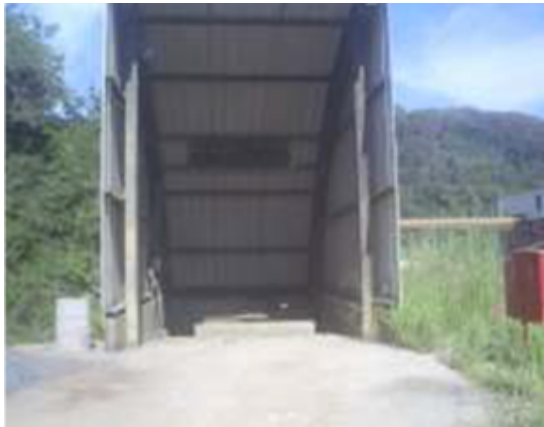
Foto 02. Galpão de recebimento do resíduo líquido.
