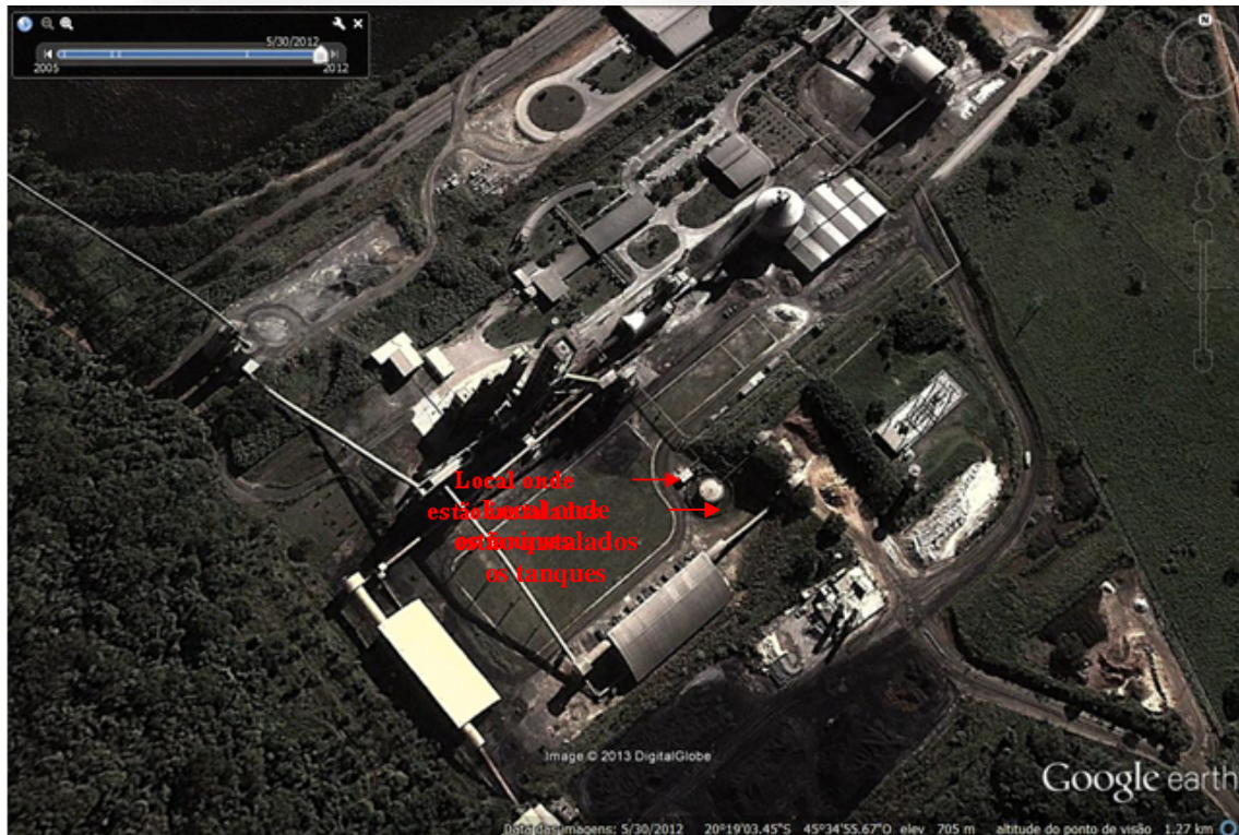
Foto 01. Visão geral da fábrica de cimento (destaque para os tanques de armazenamento dos resíduos líquidos).
