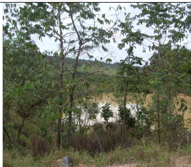
Foto 11: Dique de contenção de águas pluviais
