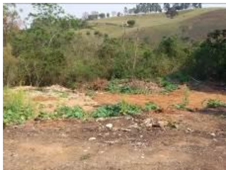
Foto 05. Área com resíduos de construção civil (antes da adequação)
