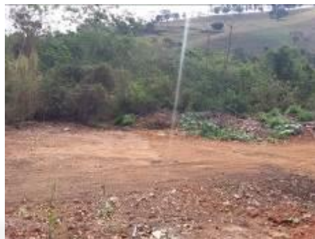
Foto 06. Área sem resíduos de construção civil (após adequação)
