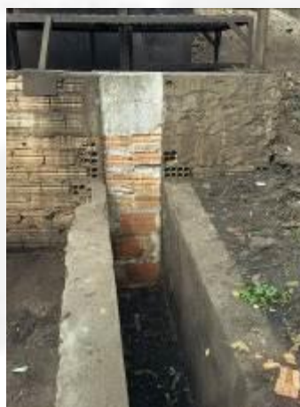
Foto 10. Contenção da elevatória sem vazamento (após adequação)
