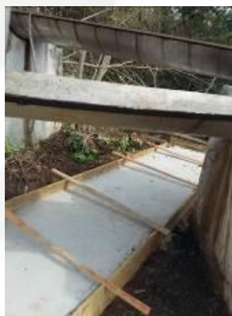
Foto 08. Rede pluvial próxima à elevatória (após adequação)
