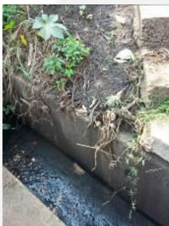
Foto 07. Rede pluvial próxima à elevatória (antes da adequação)
