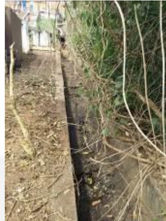
Foto 12. Rede pluvial, após elevatória, sem recebimento de efluente bruto, solo impregnado retirado (após adequação).
