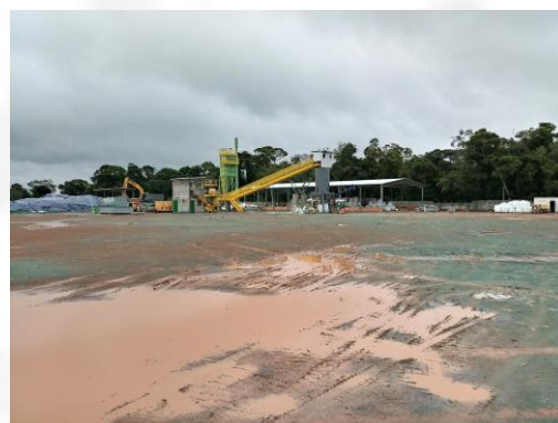
Área para implantação do Empreendimento.
