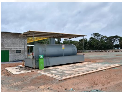
Ponto de abastecimento existente.
