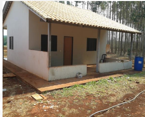
Foto 02. Casa existente, que servirá de apoio às obras
