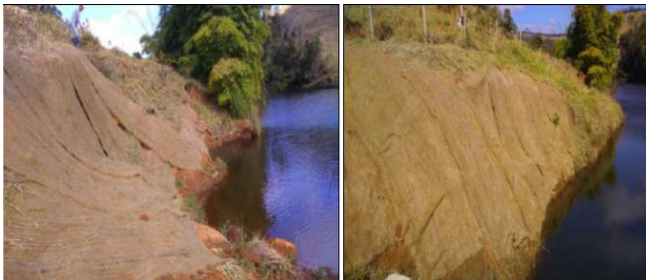
Figura 1 - Recuperação de parte da margem do reservatório
