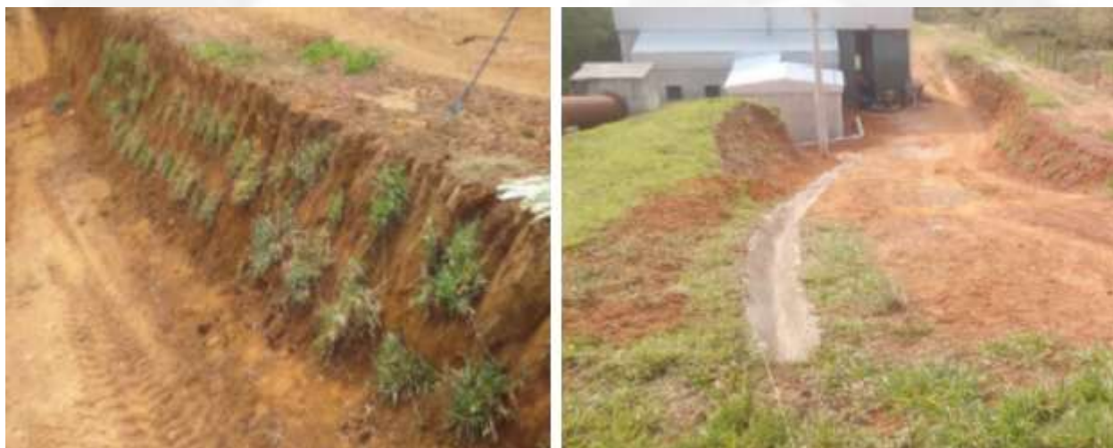
Figura 2 - Controle de erosão e drenagem de águas pluviais
