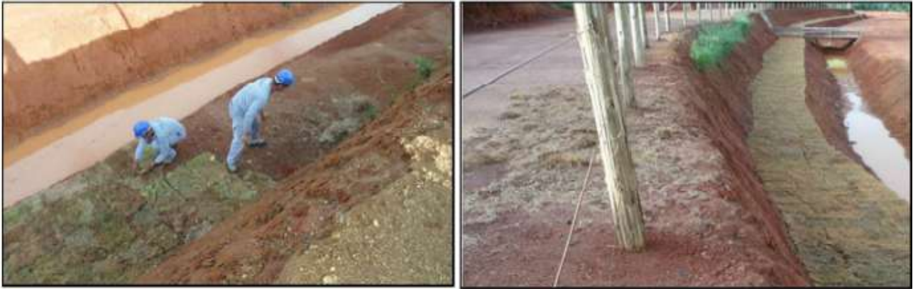
Figura 3 - Plantio de grama para prevenção de erosões
