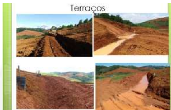
Figura 13: Mostra um trator construindo um terraço, terraços construídos e retendo água pluvial. Fonte: Votorantim - CBA
