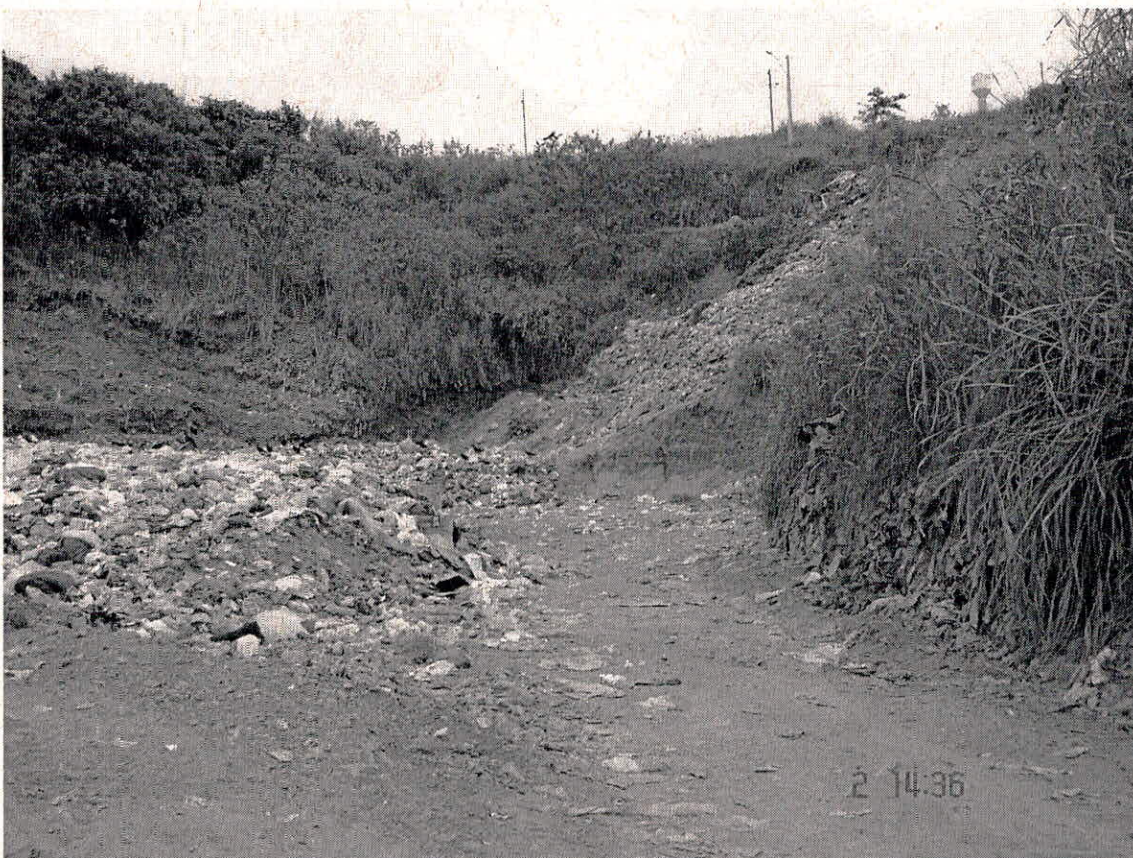
Foto 04 – Observou-se que os resíduos estavam sendo carregados a jusante da área por não conformidade das plataformas e pela falta de sistema de drenagem pluvial.
