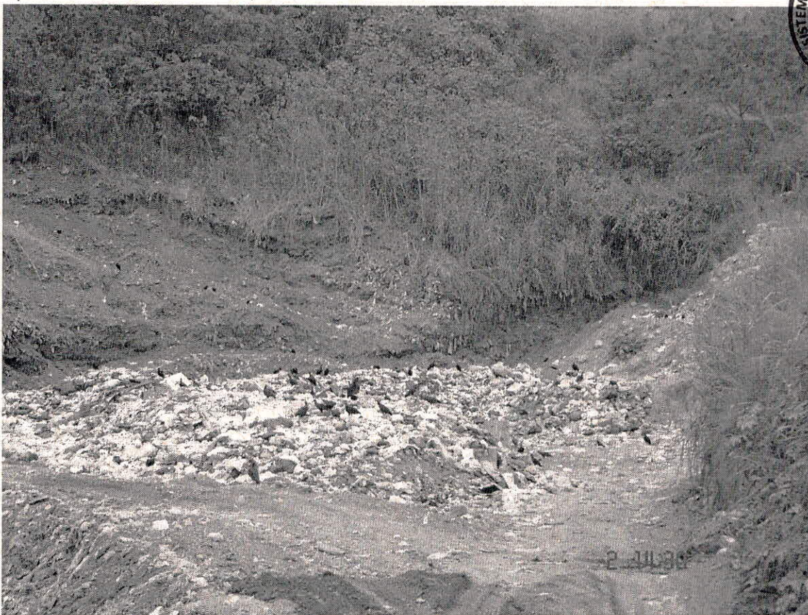
Foto 03 – Vista parcial da plataforma de disposição resíduo. Observou-se muito lixo exposto a céu aberto sem critério técnico.
