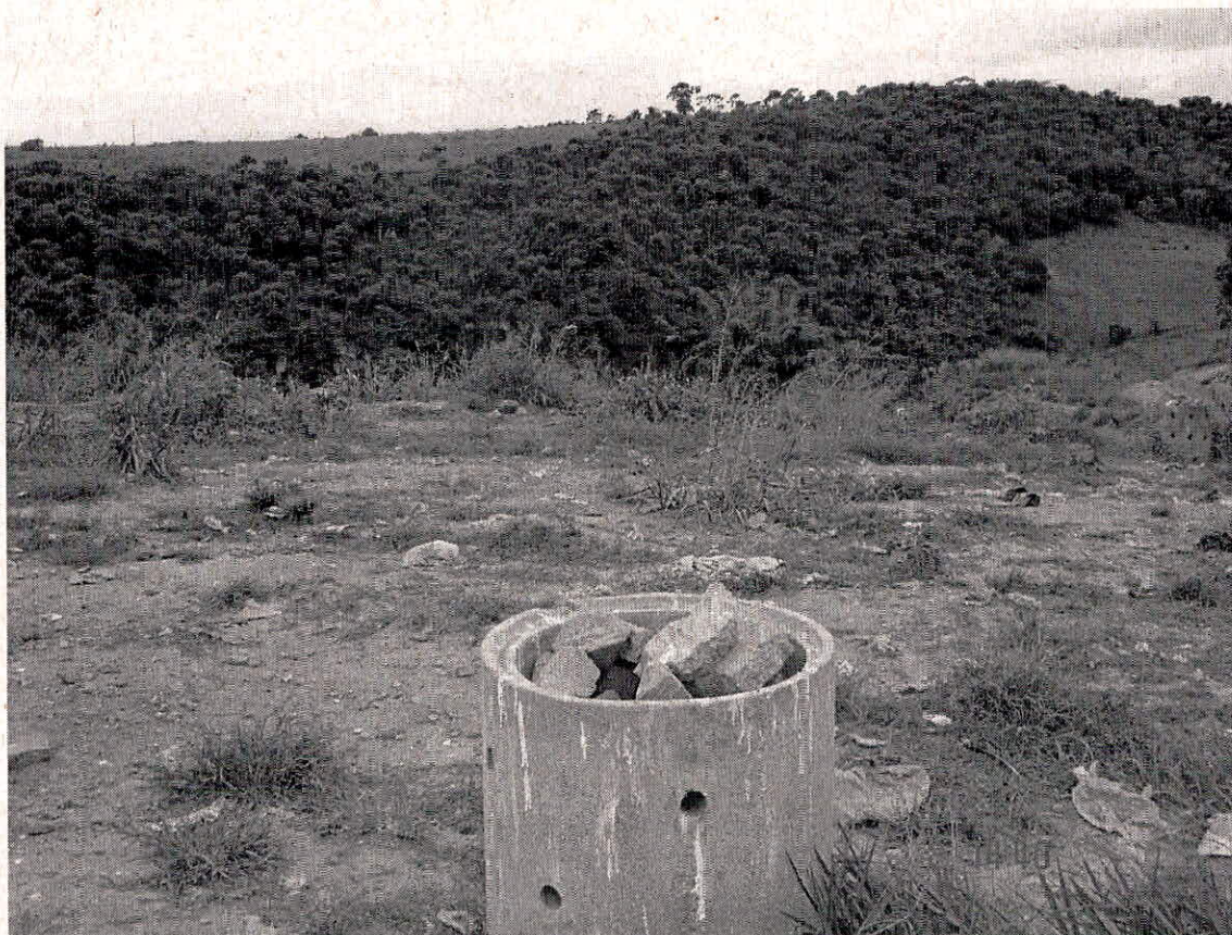
Foto 08 – Os drenos de gases instalados encontravam-se inoperantes.
