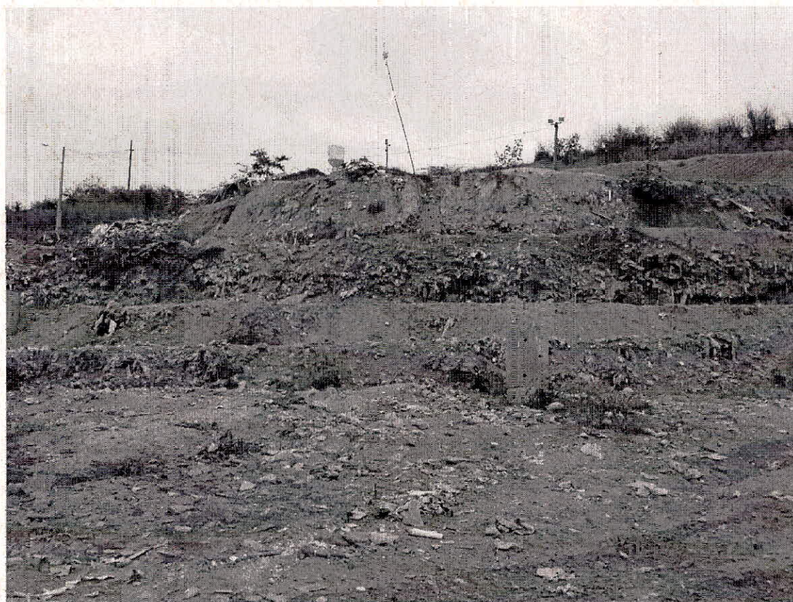
Foto 02 – Identificou-se disposição aleatória dos resíduos na plataforma de aterramento.
