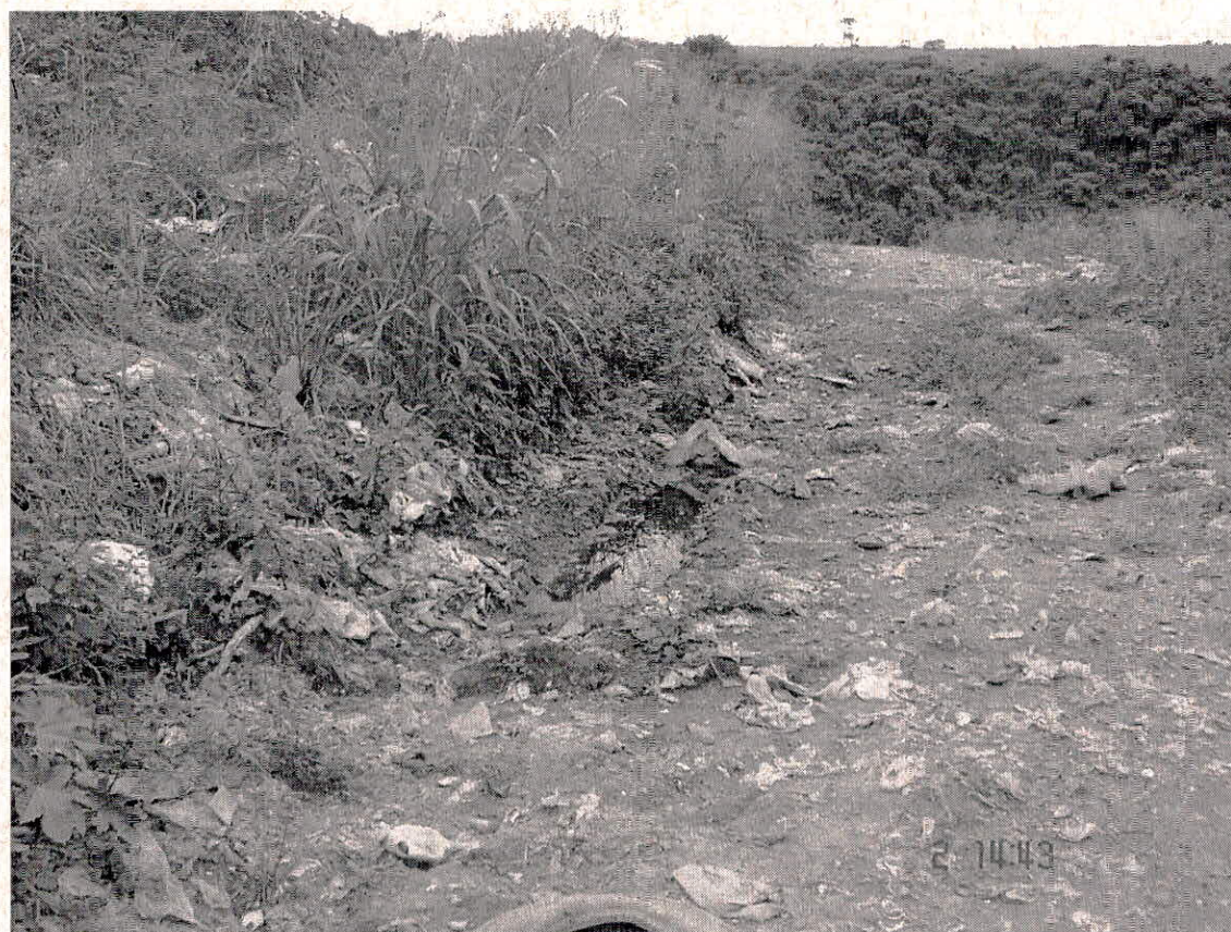
Foto 06 – Constatou-se afloramento de chorume no pé da plataforma de aterramento dos resíduos.
