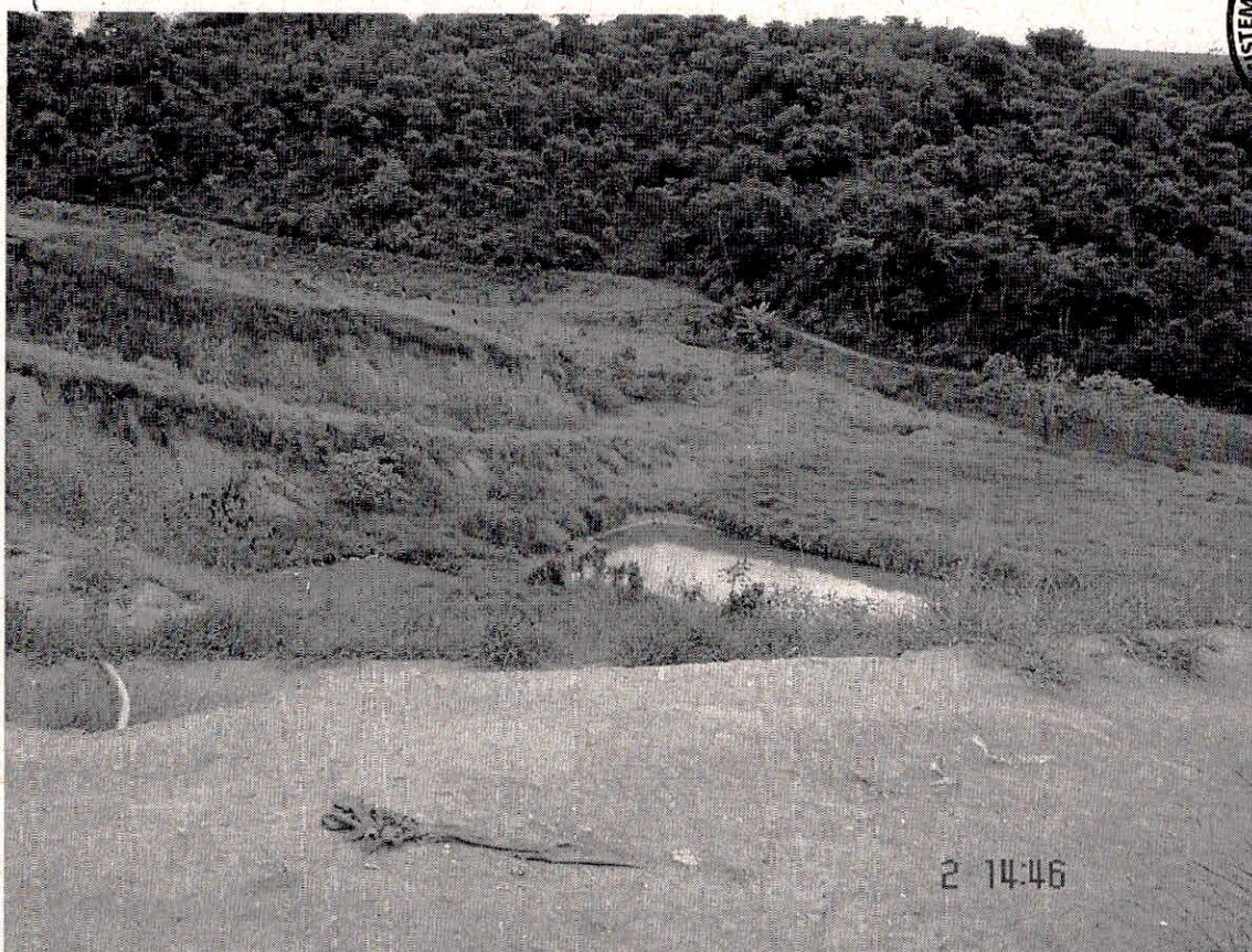
Foto 07 – Identificou-se duas lagoas de estabilização em péssimas condições de manutenção, para recolhimento de chorume dos maciços de lixo, porem a tubulação encontrava-se inoperante.
