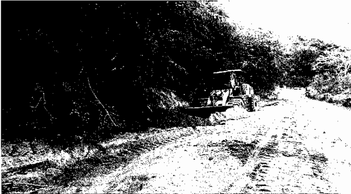
Foto 5: Reestruturação dos canais de drenagem
