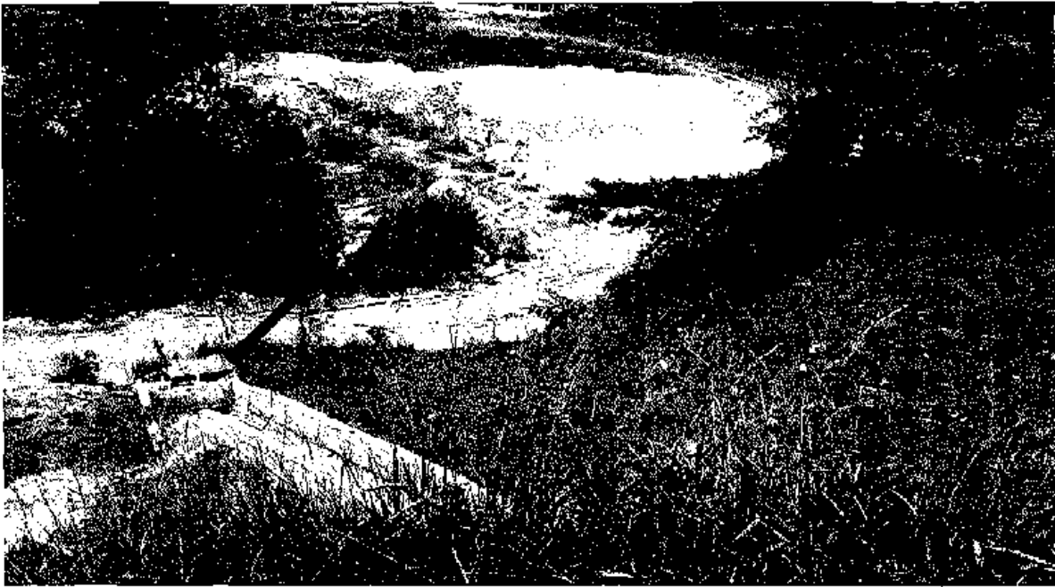
Foto 18: Dique de contenção e conversão da maior parcela da drenagem para seu interior
