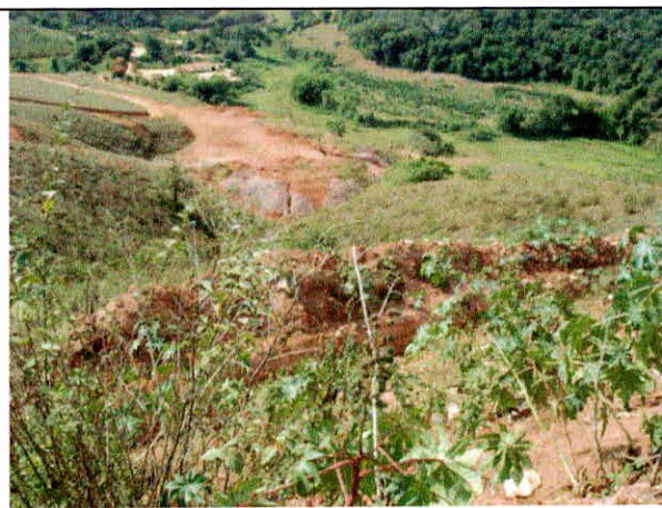
Foto 04: Drenagem pluvial por meio de calhas escavadas no solo.
