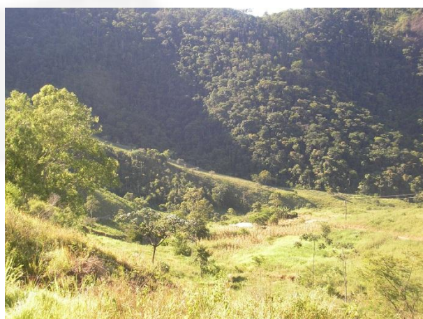
Foto 06 – Vista do ponto de intervenção do túnel da "Prainha".
