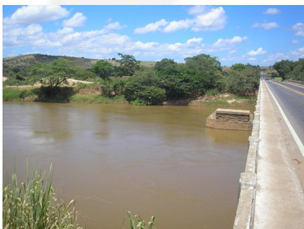
Foto 03 – área proposta à nova ponte sobre o rio Santo Antônio.
