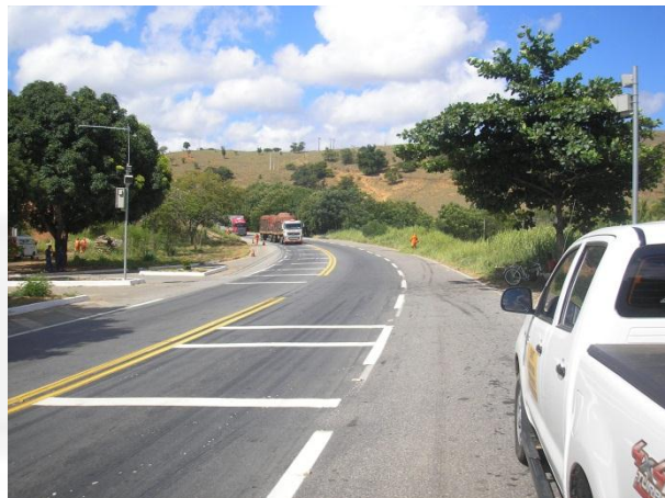
Foto 02 – local com pista de acesso lateral projetada (Distrito de Baguari).
