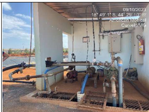
Estação elevatória - Bombeamento dos efluentes líquidos para rede da COPASA-MG
