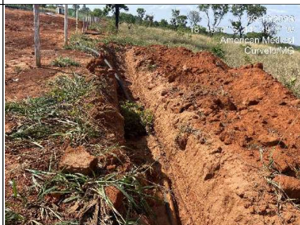
Tubulação/rede emissária para lançamento de efluentes líquidos na rede da COPASA-MG
