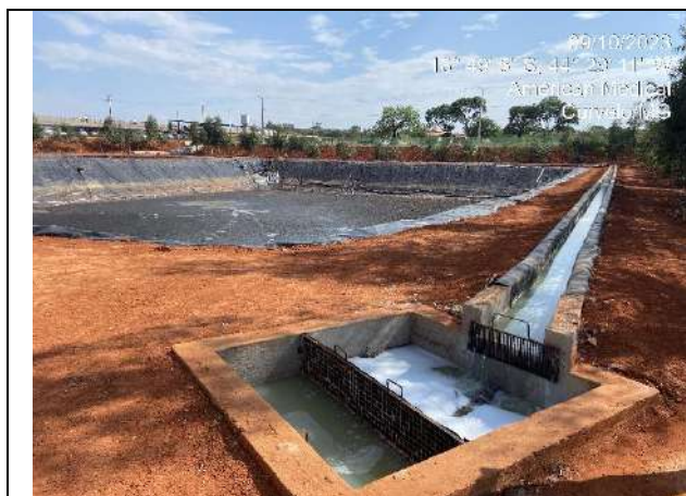
Saída dos efluentes industriais dos canais de arrefecimento de temperatura e lagoa com PEAD
