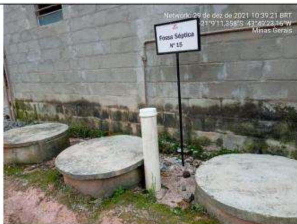
4 - Fossa séptica instalada junto a cada galpão.
