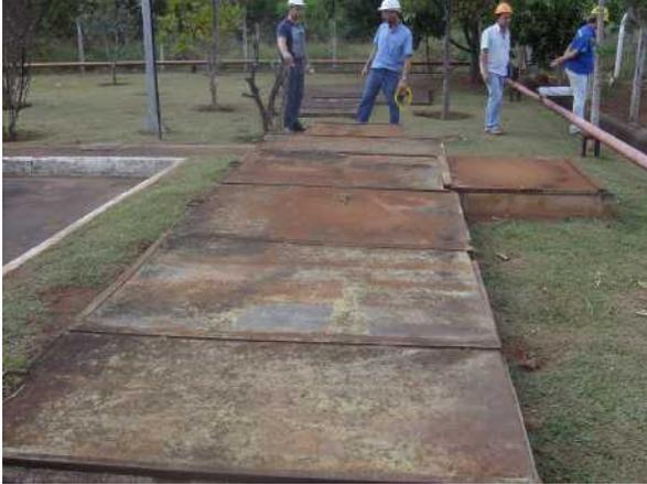
**Foto 05.** Caixa Separadora de Água e Óleo - CSAO
