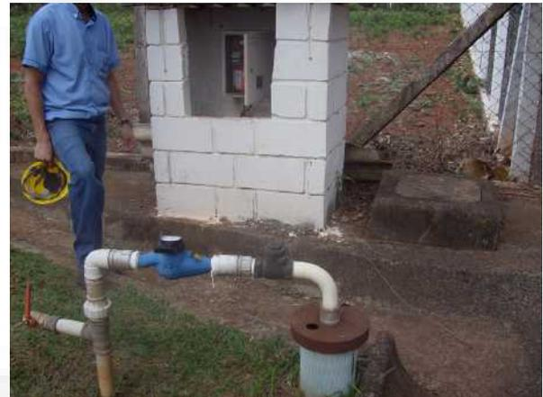
**Foto 08.** Poço tubular utilizado no empreendimento – horímetro e hidrômetro
