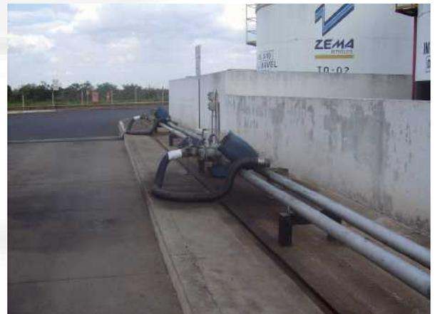
**Foto 02.** Área de descarga e bacia de contenção dos tanques.
