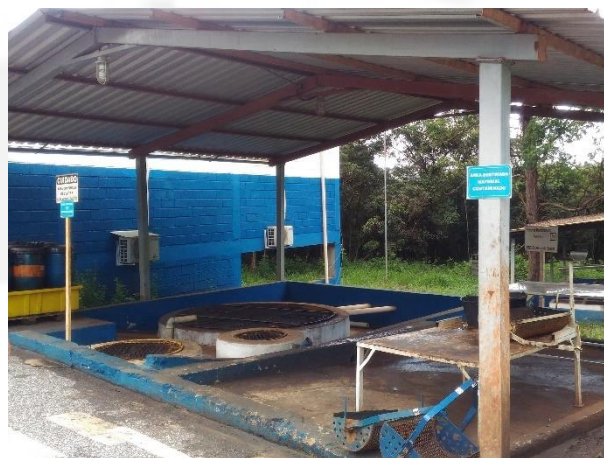
FOTO 6 – Depósito de resíduos perigosos.
