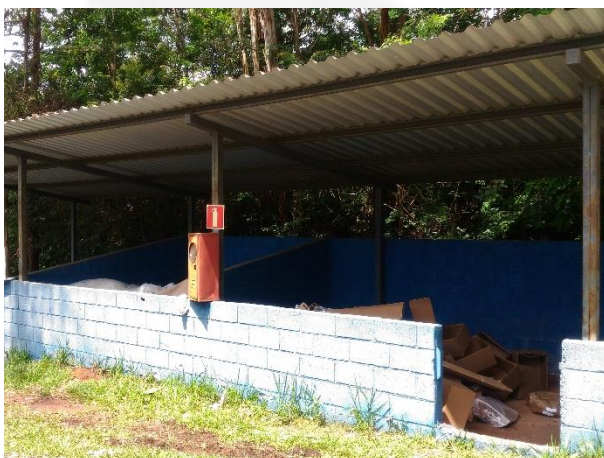
FOTO 5 – Depósito de resíduos recicláveis.
