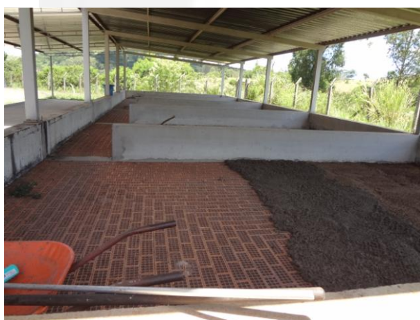
Foto 03. Leito de Secagem do lodo da ETE.
