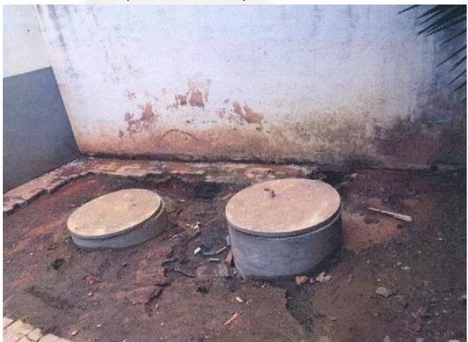
Foto 05- Sistema de Fossa Séptica e Filtro Anaeróbio.
