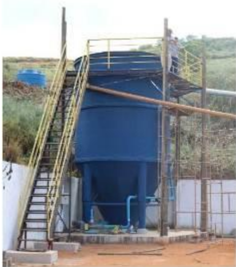
Figura 12: Vista geral do decanter (Fonte RCA)
