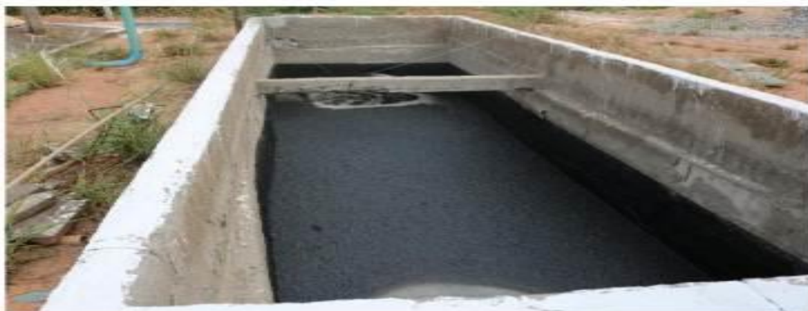
Figura 10: tanque receptor dos efluentes do biodigestor (Fonte RCA)
