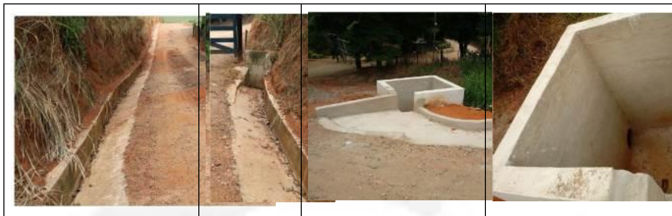
Figura 23: Estruturas de coleta e transporte das águas pluviais (Fonte RCA)
