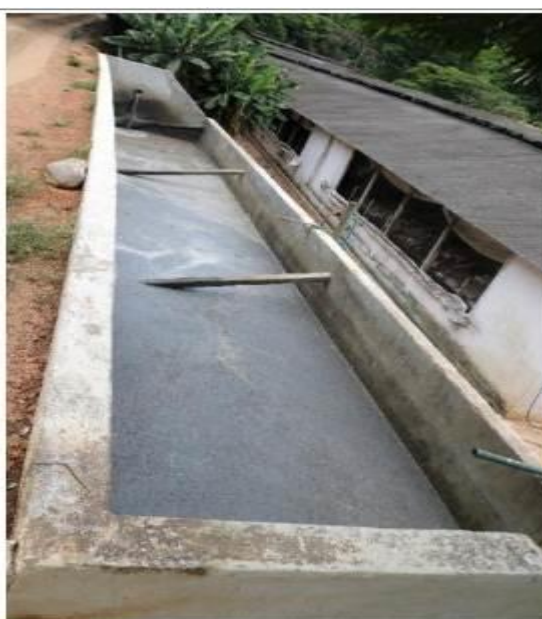
Figura 8: Tanque equalizador (Fonte RCA)
