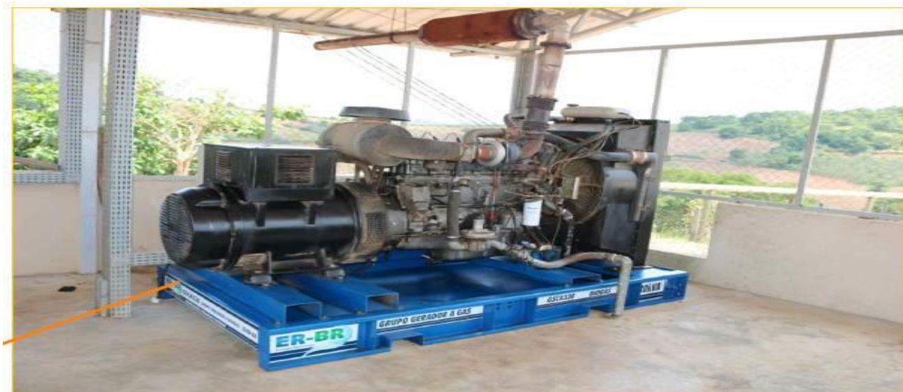
Figura 04: Grupo motor gerador alimentado a biogás. – Fonte: Relatório de Controle Ambiental (RCA)
