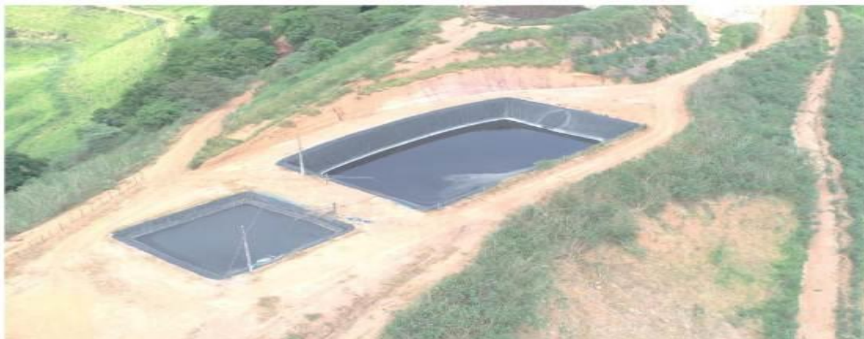
Figura 14: lagoas impermeabilizadas de armazenamento de efluentes. (Fonte RCA)
