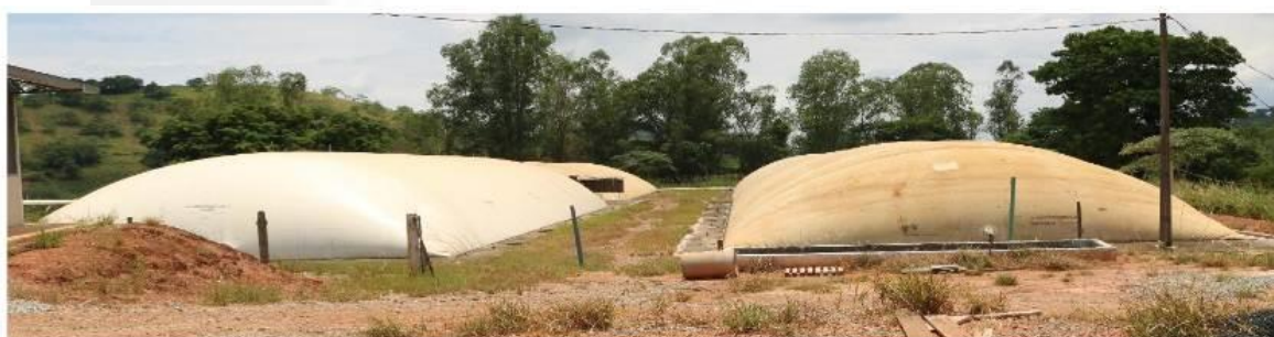
Figura 9: Biodigestores (Fonte RCA)
