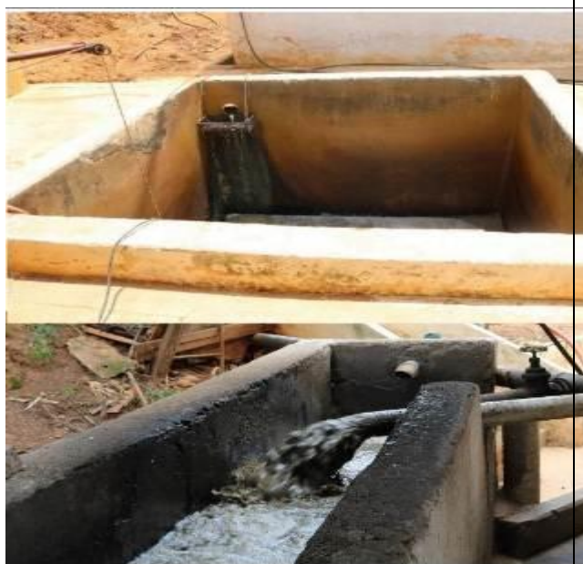
Figura 7: Rede coletora de efluentes (Fonte RCA)
