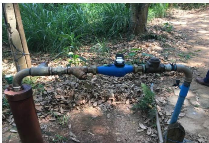
Captação em poço tubular com horímetro e hidrômetro
