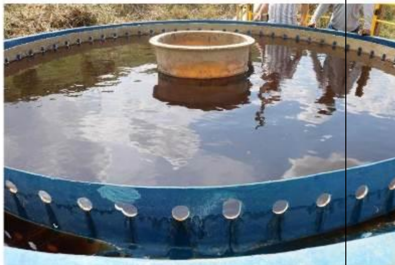
Figura 13: Vista superior do decanter. (Fonte RCA)
