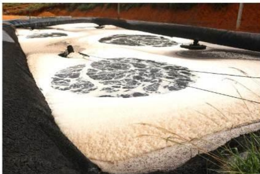
Figura 11: Lagoa aerada impermeabilizada com geomembrana PEAD (Fonte RCA).
