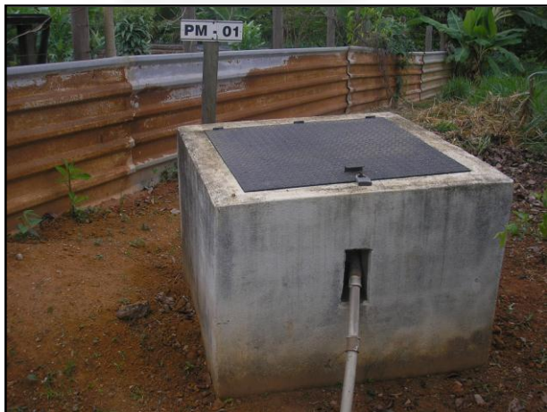
Foto 03: Poço de monitoramento a montante do maciço.
