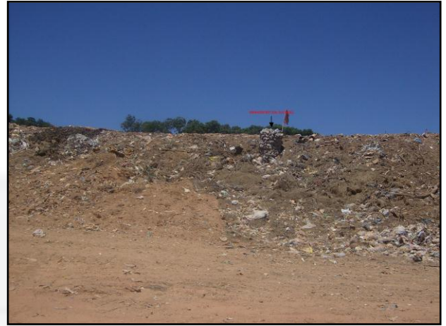
Foto 02: Frente do maciço e dreno vertical dos gases.
