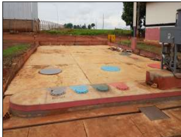
Figura 2: Tanques subterrâneos, filtros e pista de descarga.
