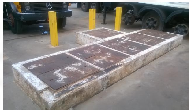
Foto 04. Caixa Separadora de Água e Óleo-SAO.
