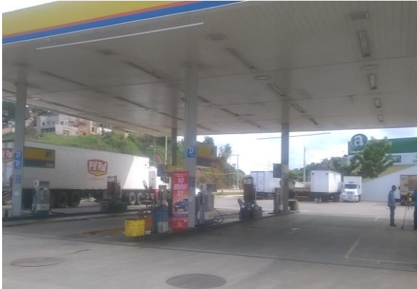
Foto 01. Vista geral da pista de abastecimento.
