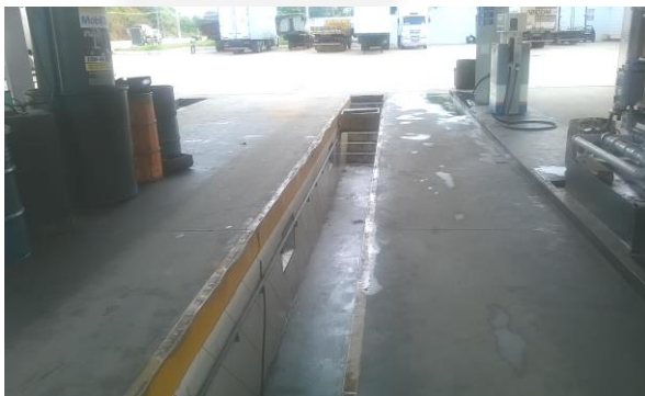
Foto 03. Pista para troca de óleo de caminhões.
