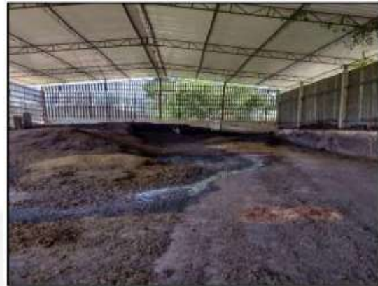
Foto 06. Galpão de compostagem
